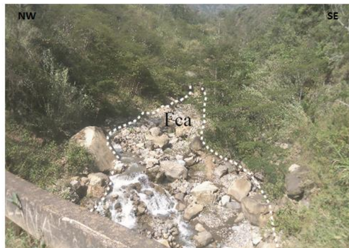
Figura 45. Cauce fluvial activo a 800 m del cruce de la vía San Andrés-la Laguna de Ortices, margen izquierdo de la carretera
