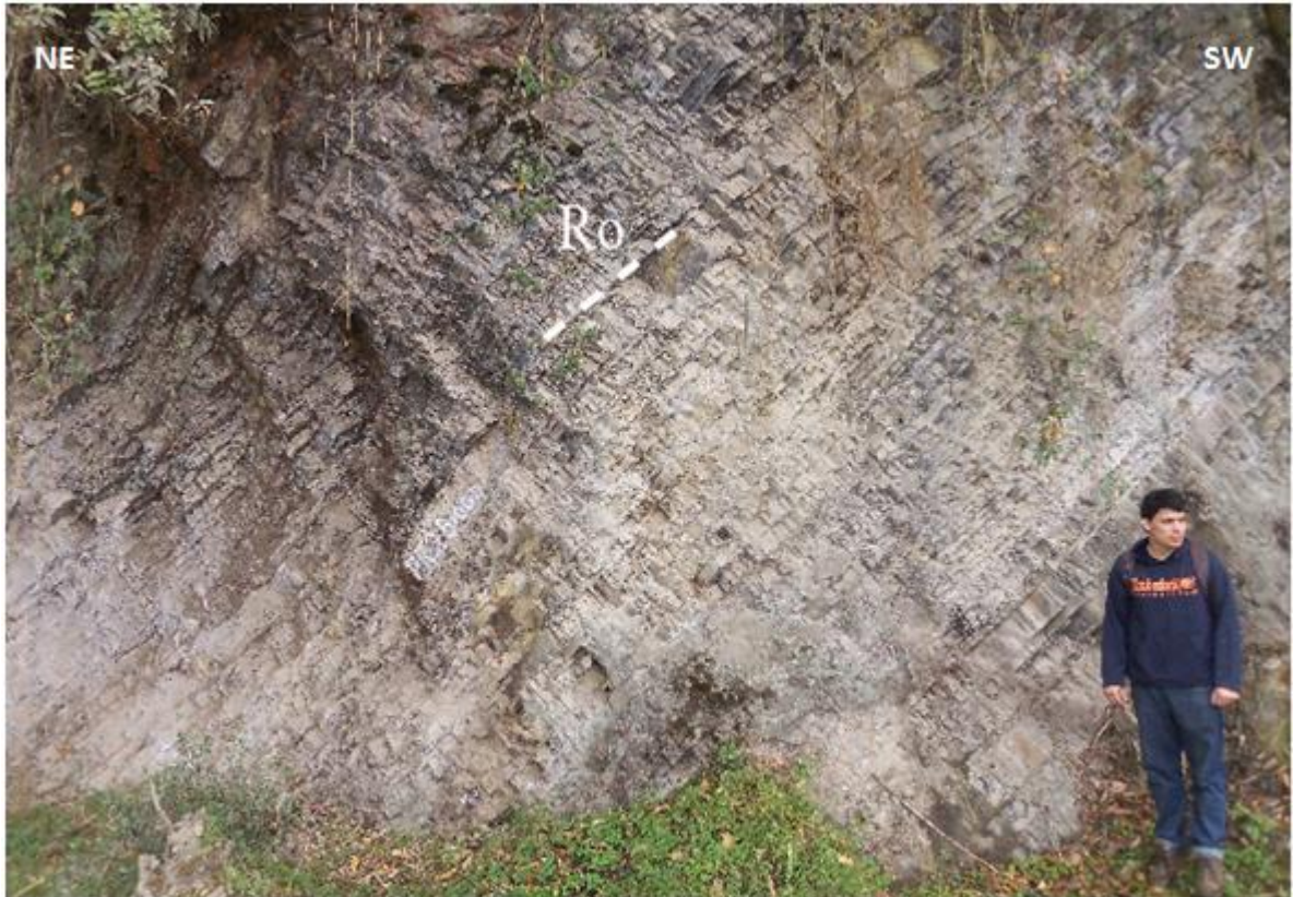
Figura 61. Macizo rocoso ubicado en la vía Pangote-Málaga, hacia el margen izquierdo de la carretera.
