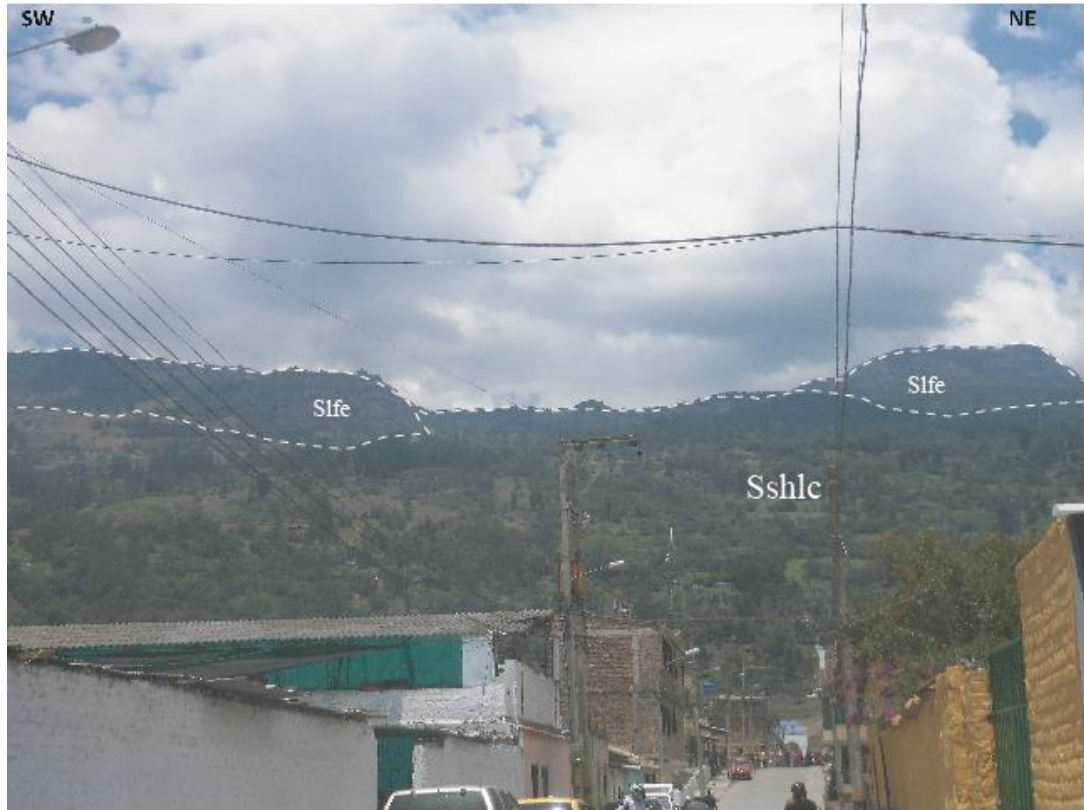
Figura 50. Escarpe de línea de falla hacia el oeste del municipio de Málaga.
