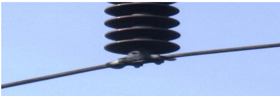
Figura 20. Grapa de suspensión para 115 kV
