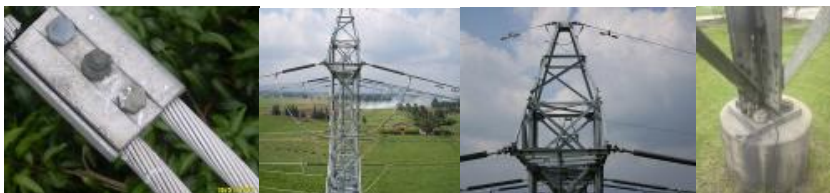
Figura 33. Componentes de una LLTT
