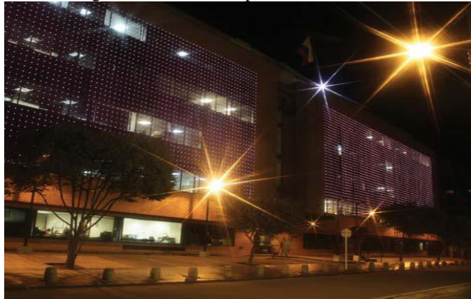
Figura 2. Edificio corporativo CODENSA.
