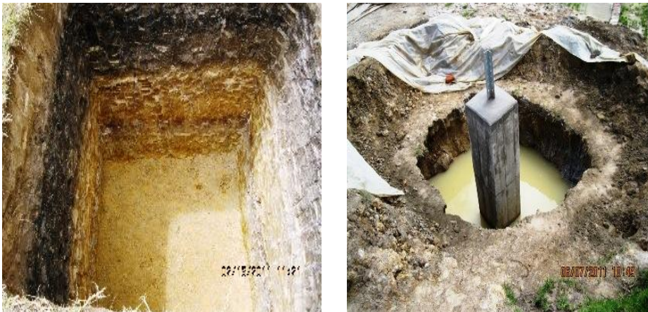
Figura 27. Excavación para cimentación y base
