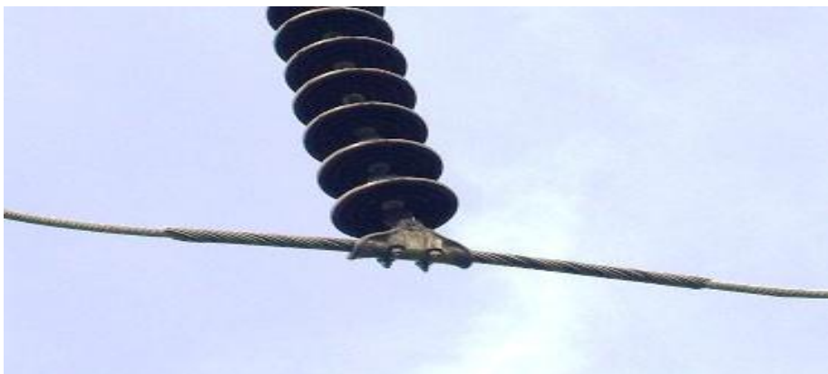
Figura 23. Varillas de blindaje para 115kV
