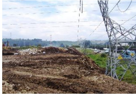
Obras civiles y remoción de tierras
