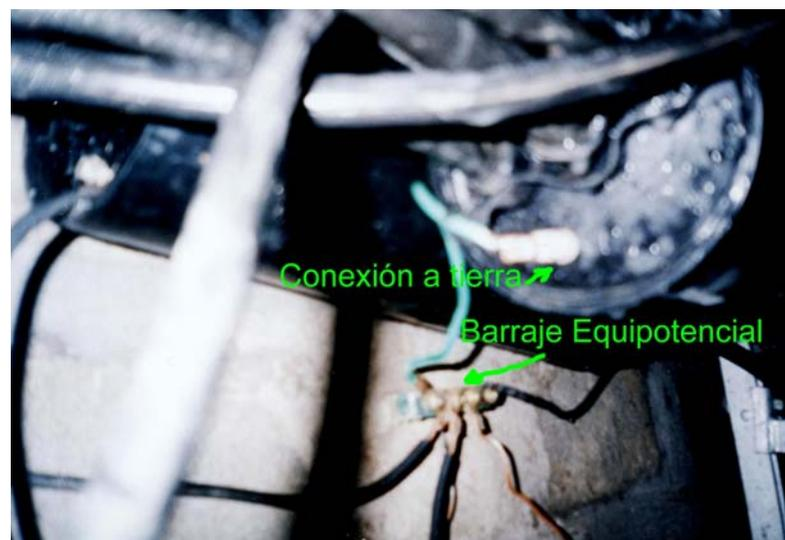
**Figura 7. Conexión equipotencial.**
