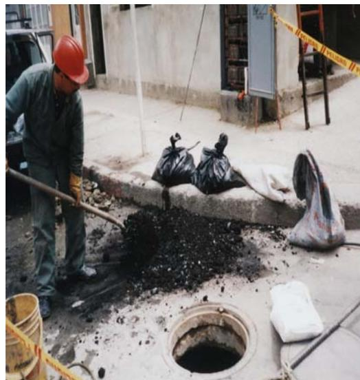
**Figura. 29. Mezcla para un SPT de cámara**
