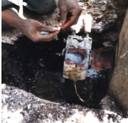
**Figura. 33. Preparación de la conexión exotérmica.**
