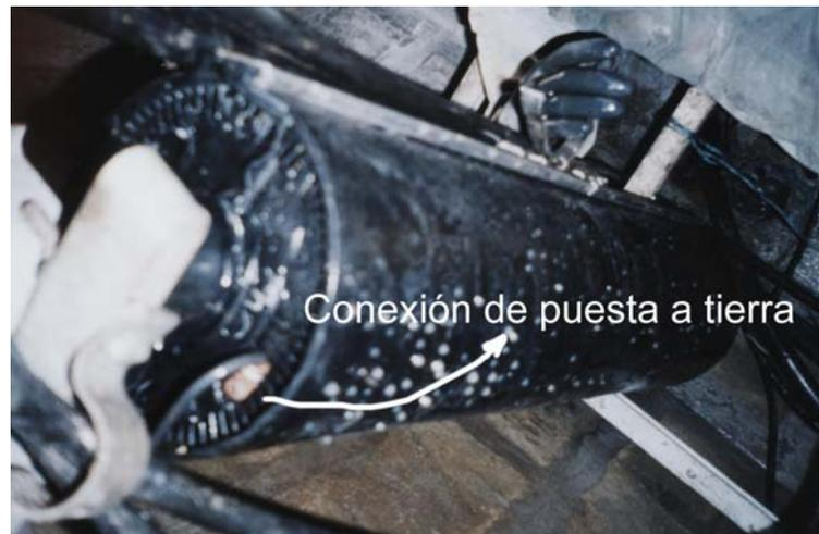
**Figura 6. Conexión a tierra en el manguito de cámara**
