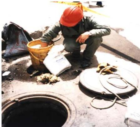
**Figura 30. Preparación de la Hidrosolta.**
