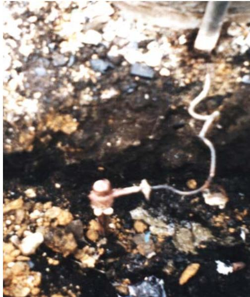
**Figura 35. Conexión exotérmica del electrodo**
