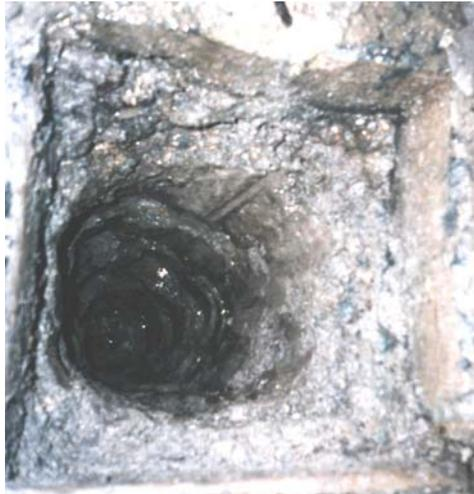
**Figura 27. Pozo de puesta a tierra de cámara subterránea.**
