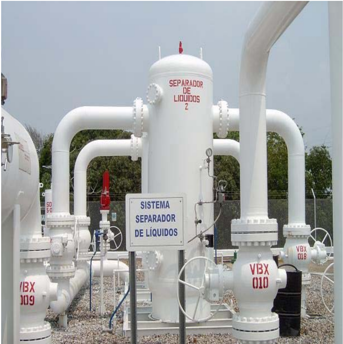
Figura 7. Sistema de Separación de la estación Barrancabermeja
