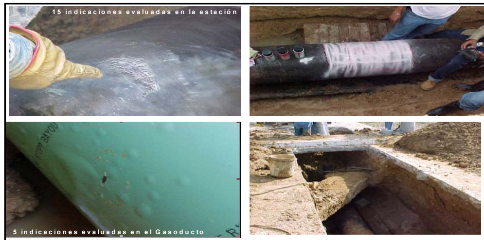
Figura 28. Excavaciones para instalar la herramienta “Teletest” y evaluar el estado de la tubera
