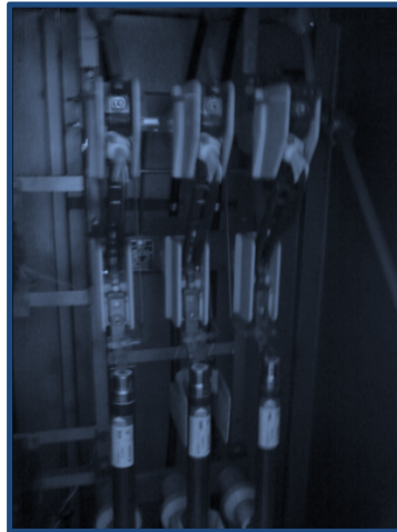
FIGURA 10. Seccionador bajo carga y fusibles
