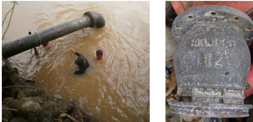
Figura 31. Línea de succión y válvula de pie
