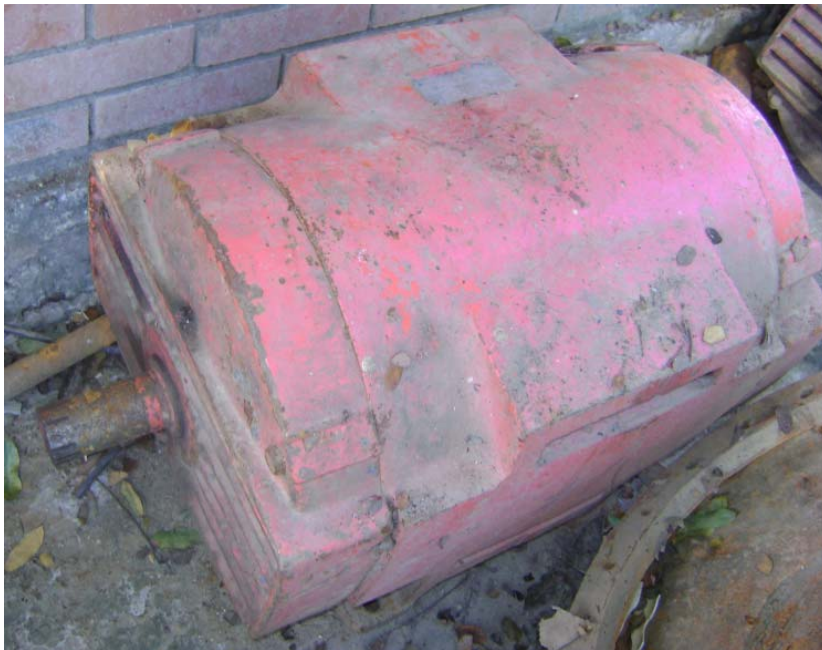
Figura 10. Motor eléctrico sistema de bombeo N° 1
