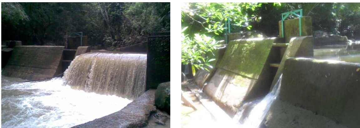
Figura 3. Captación tipo dique construida en el año de 1955
