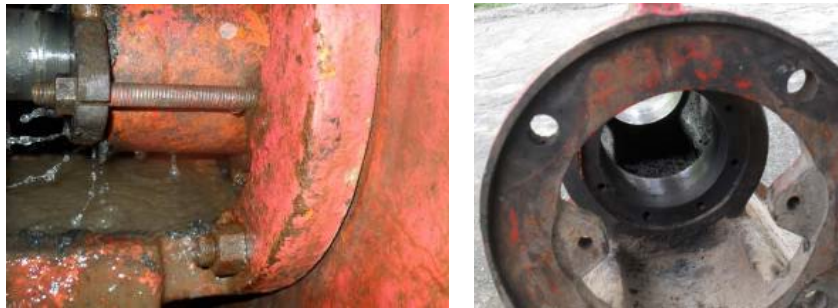
Figura 11. Escape por prensa estopa y cuerpo de la bomba
