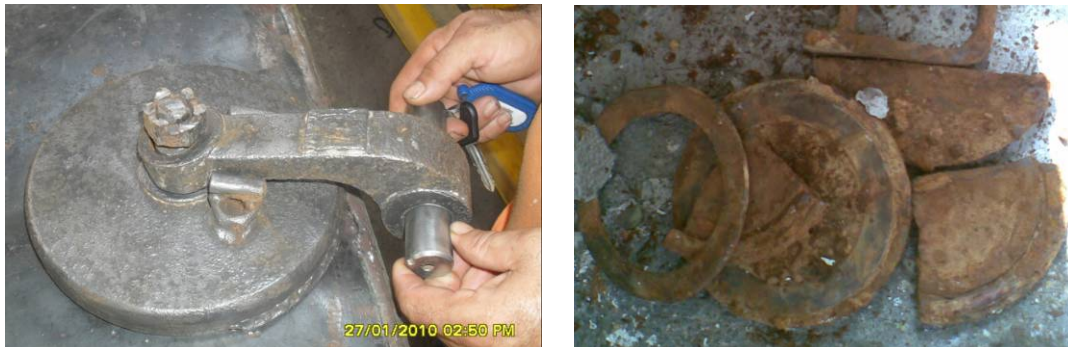
Figura 30. Internos de cheques y válvulas de descarga
