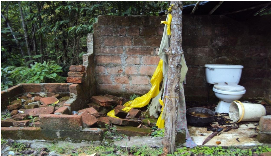
Sanitarios de la piscicultura construidos por la Corporación Ecológica de Turbay. 123
