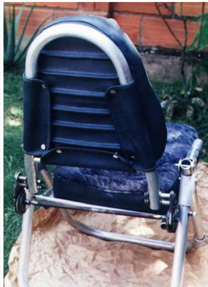
El sistema de sujeción de los almohadones a la estructura metálica, se logra mediante resortes que trabajan a flexión como vigas. Además de este los cojines poseen chapetas que abrazan la tubería estructural para dar mayor seguridad.
