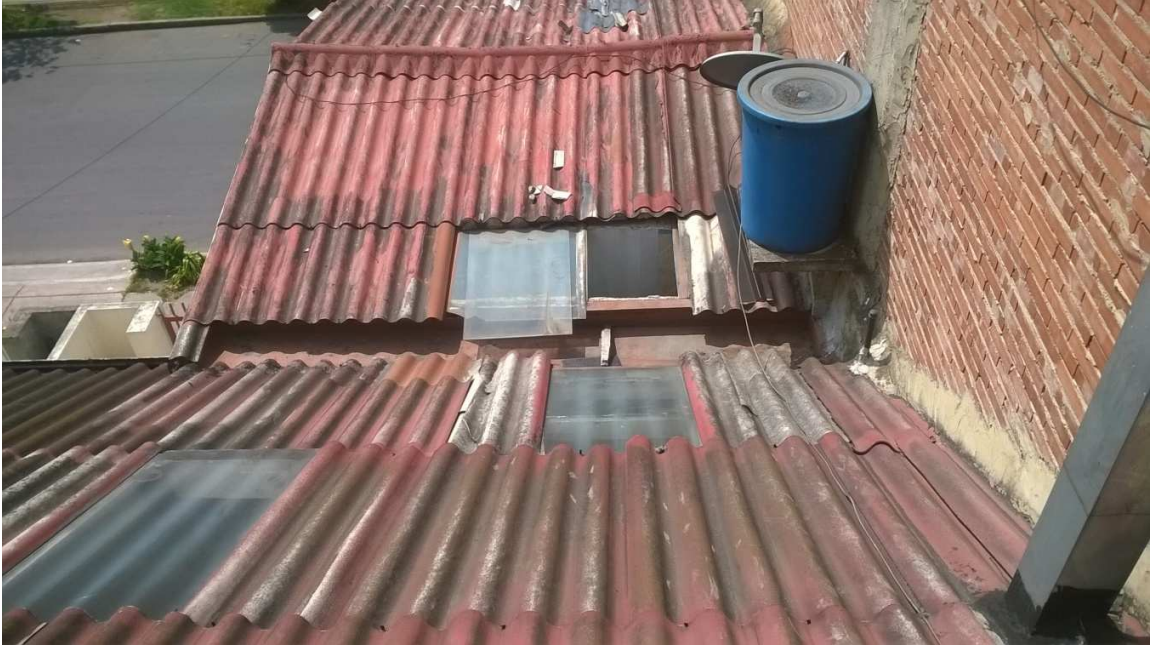
Fotografías No. 2 y 3 Acondicionamiento cubierta (área de captación)
