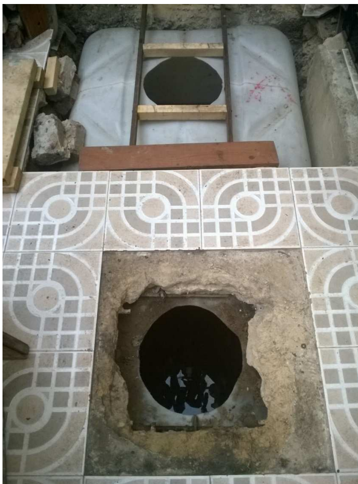
Fotografía No. 6 Batería de tanques (cisterna) enterrados en el patio.
