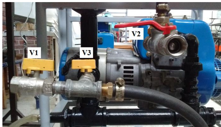
Figura 20 Válvulas de admisión y recirculación del sistema complementario
