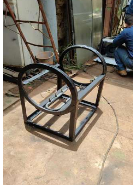
Figura M.5. Estructura recubierta con pintura anticorrosiva de alta temperatura.
