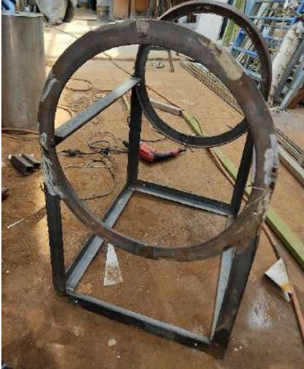
Figura M.4. Estructura hecha mediante soldadura en anguleria A36 3/16.
