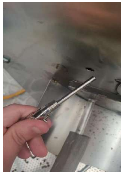
Figura M.27. Perforación y instalación del sensor de temperatura tipo k
