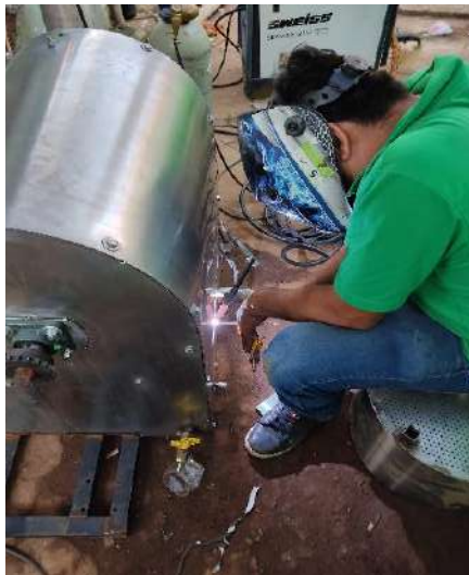
Figura M.24. Instalación de tubería a los quemadores.
