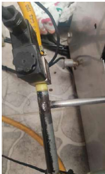
Figura M.26 Instalación de válvula solenoide a la tubería.
