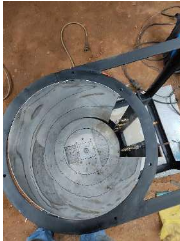
Figura M.13. Alineación de la lámina de acero inoxidable en la estructura.
