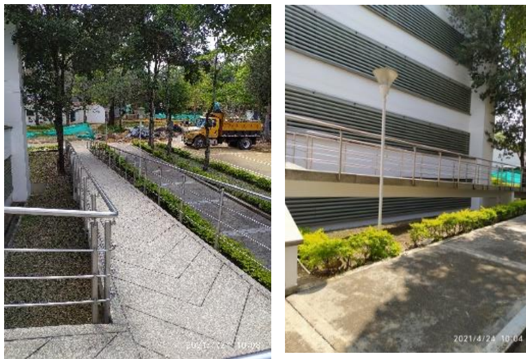
Rampa de acceso del edificio de la EEIE
