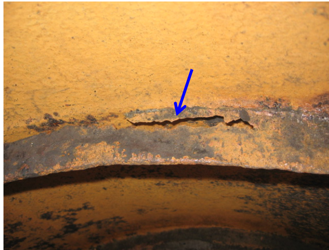
Figura 32. Estado del soporte del plato número 20. Torre de destilación Atmosférica 46 .
