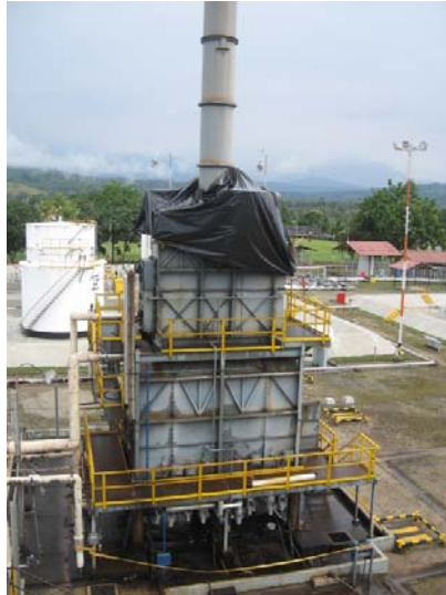
Figura 6 Horno Dual Tipo Cabina (Refinería Orito-Putumayo) 14
