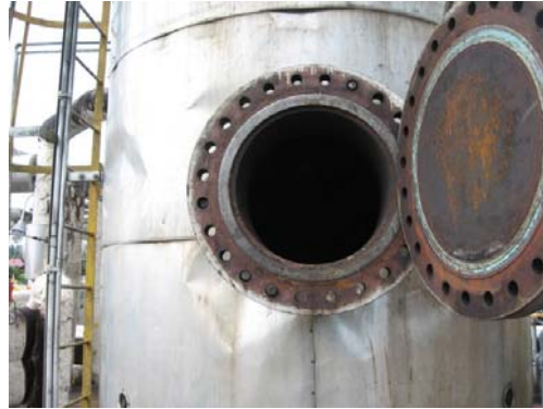
Figura 43. Estado del Foil de Aluminio en el desalador D5. 57
