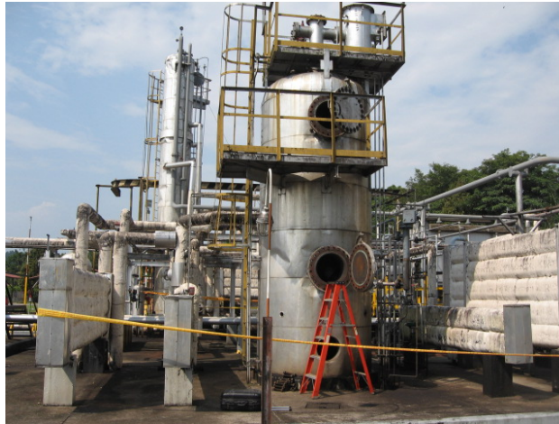
Figura 10 Desalador de crudo D5. 18
