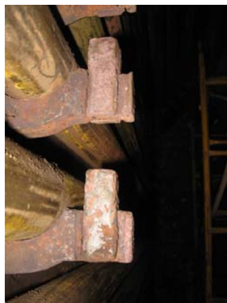
Figura 18. Soportes y Cuñas con Presencia de Sulfidación 32 .
