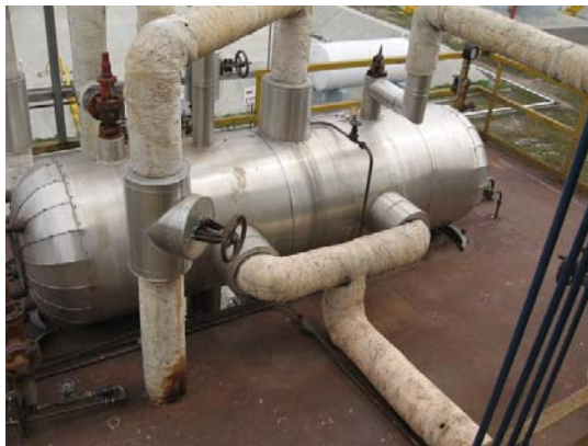
Figura 24. Vista externa del domo de vapor D7. 38
