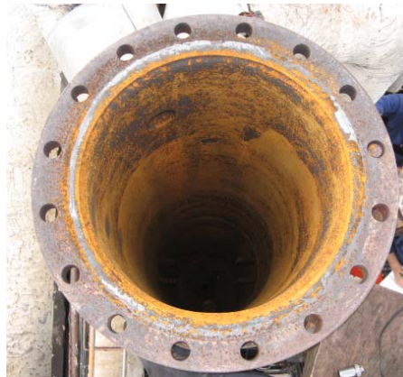
Figura 37. Estado del la brida de la Despojadora D2. 51
