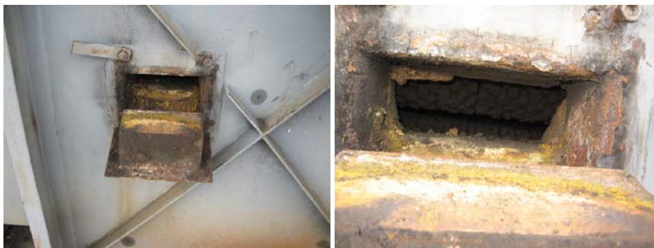
Figura 29. (a) y (b) Estado del refractario en las mirillas. 43
