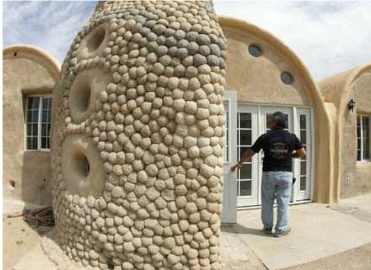
Figura 1-3 Construcción con esferas de tierra Tomado www.wikipedia.com
