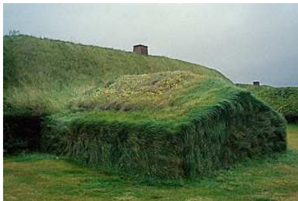
Figura 1-4 Construcción en sod Tomado www.fortavikinga.blogspot
