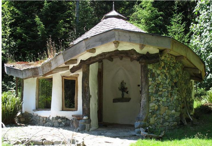
Figura 1-1 Construcción en bauge
