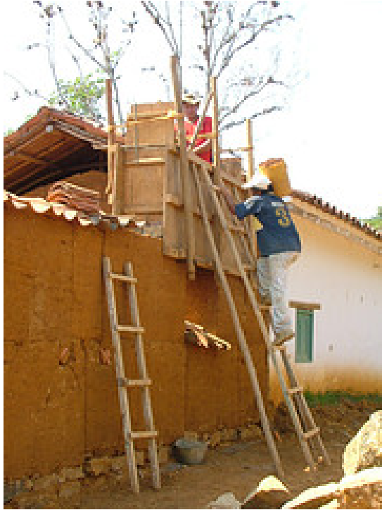
Figura 1-2 Muro en tapia pisada Tomado www.farm.1.static.flickr.com
