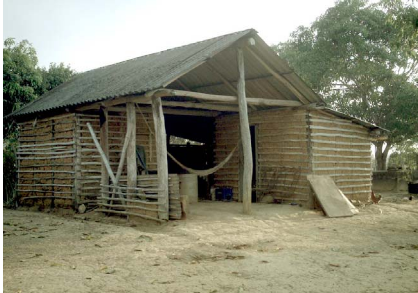
Figura 1-7 Construcción en bareque sin terminación en cal Tomado wikipedia.com
