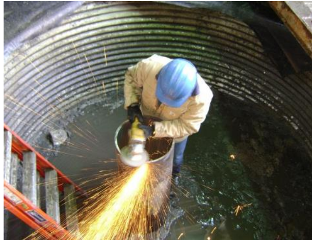
Figura 4. Casing de superficie
