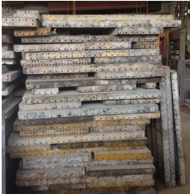
Figura 15 Almacenamiento erróneo de tableros metálicos
