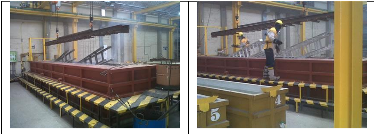
Figura 2 Planta de galvanizado, año 2012
