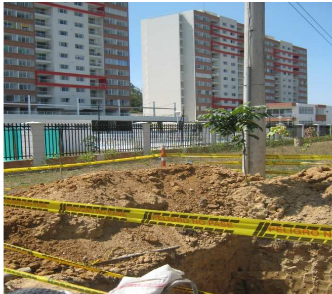
Ilustración 24. Señalización para construcción de Cámara, Anillo Vial.
