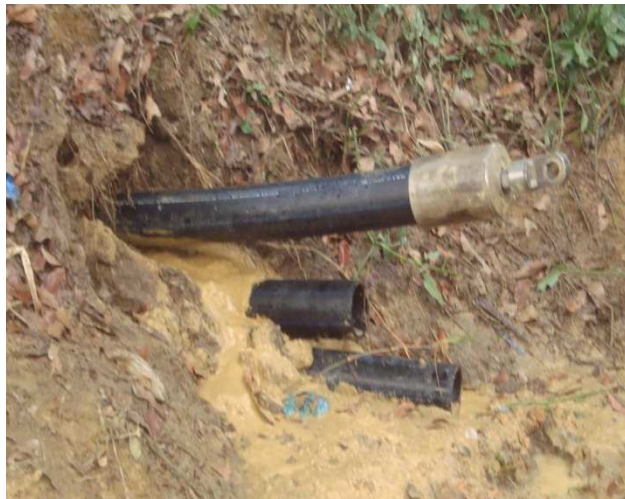
Ilustración 18. Ductos instalados en Cruce Transversal con Topo Teledirigido, Anillo Vial.
