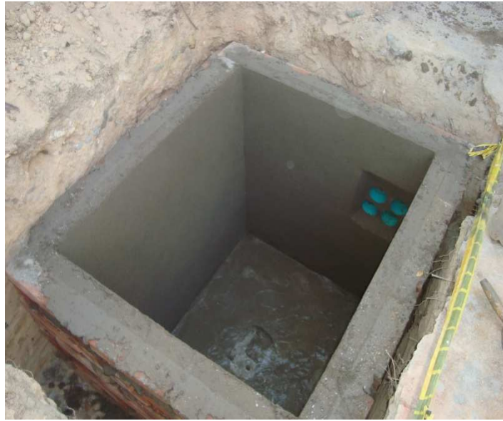
Ilustración 7. Frisado de Muros, Tramo PQP – Piedecuesta.
