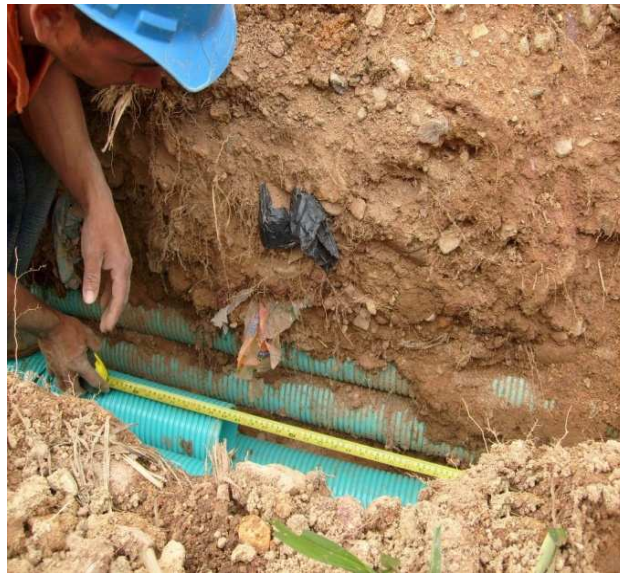
Ilustración 13. Encamisado de ductos existente, Tramo 3 (Puente Cañaverl – PQP).
