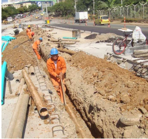
Ilustración 10. Canalización en el Separador Central, tramo 3 (Puente Cañaverál - PQP).
