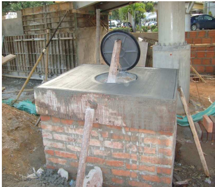
Ilustración 6. Cámara bajo el Puente Peatonal de Cañaverál, tramo 3, (Puente de Cañaverál - PQP).
