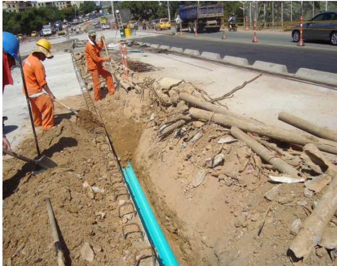
Ilustración 15. Relleno de zanja con material seleccionado, Tramo 3 (Puente Cañaverál – PQP).
