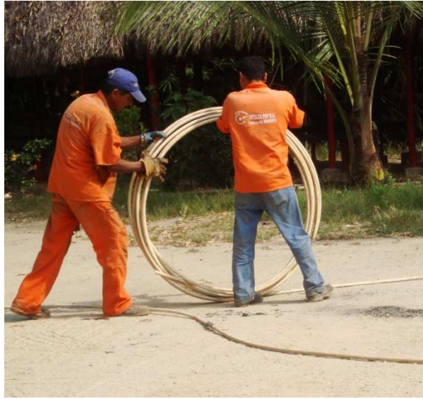
Ilustración 20. Sondeo de Ductos, Tramo PQP - Piedecuesta.
