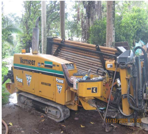
Ilustración 31. Topo Teledirigido, empleado para Cruces Transversales.
