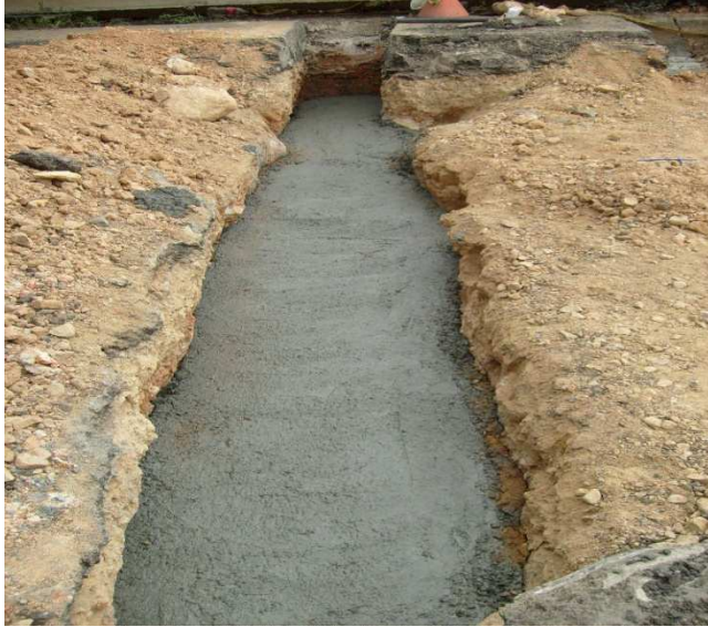
Ilustración 16. Atrache en concreto, Tramo 3 (Puente Cañaverl – PQP).
