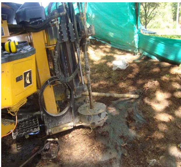
Ilustración 19. Cruce Transversal con Topo Teledirigido, Tramo PQP – Piedecuesta.
