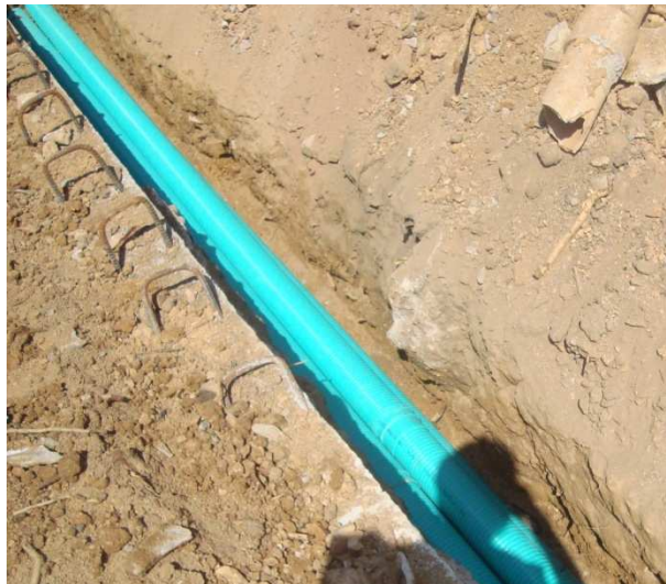
Ilustración 11. Instalación de ductos TDP, tramo 3 (Puente Cañaveral – PQP).
