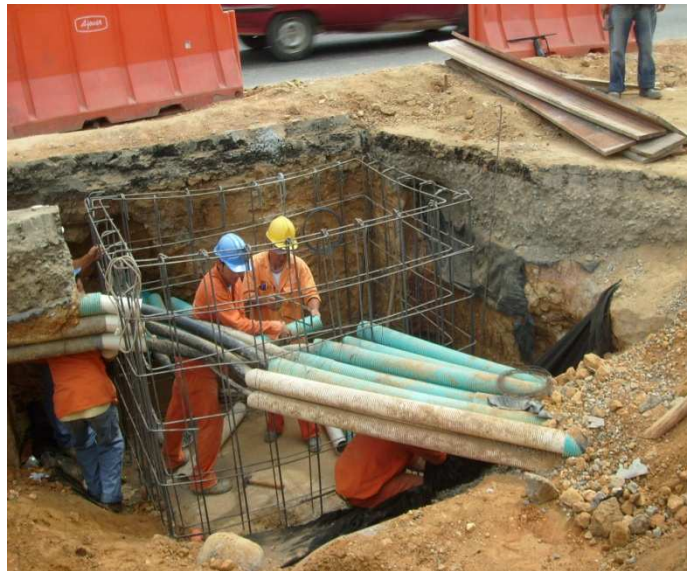
Ilustración 8. Llegada de Ductos a Cámara, Tramo 3 (Puente Cañaveral - PQP).
