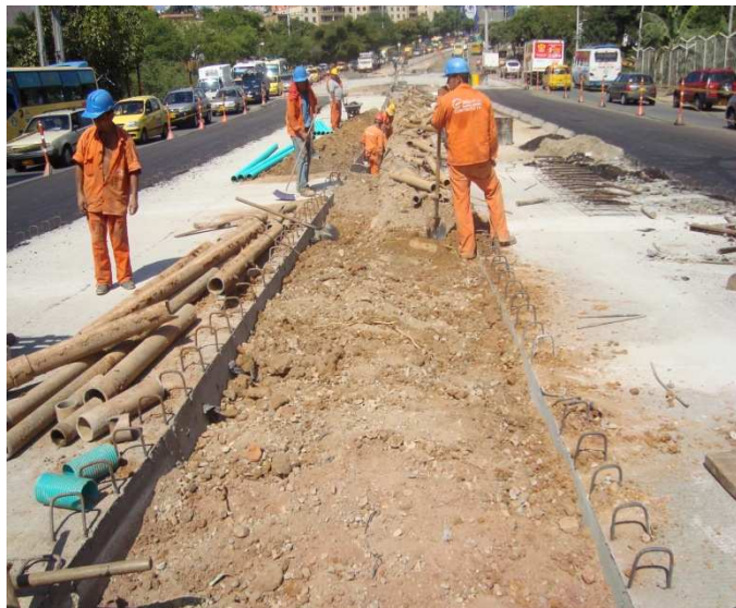
Ilustración 14. Relleno de zanja, Tramo 3 (Puente Cañaveral – PQP).
