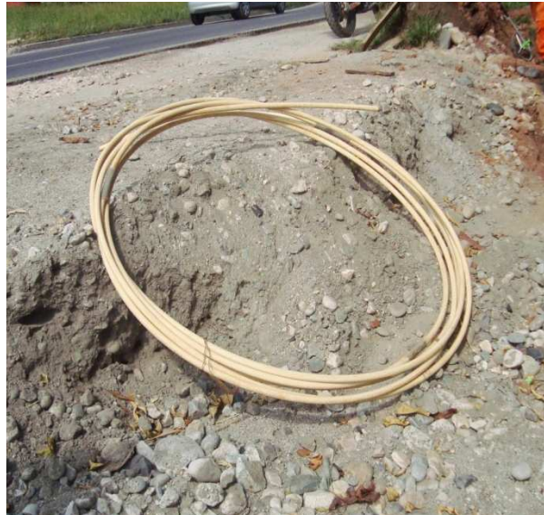
Ilustración 21. Sonda Empleada en las actividades de Sondeo de Ductos.
