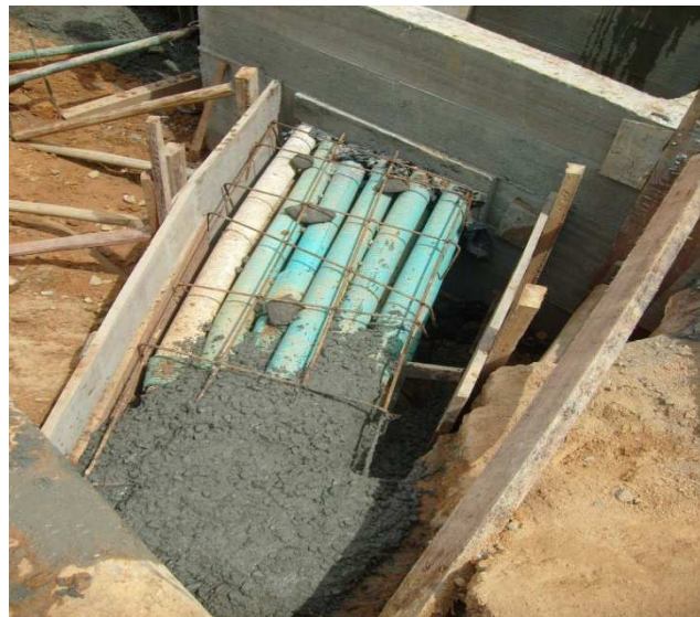
Ilustración 17. Atrache en concreto reforzado (cárcamo), Tramo 3 (Puente Cañaverl – PQP).
