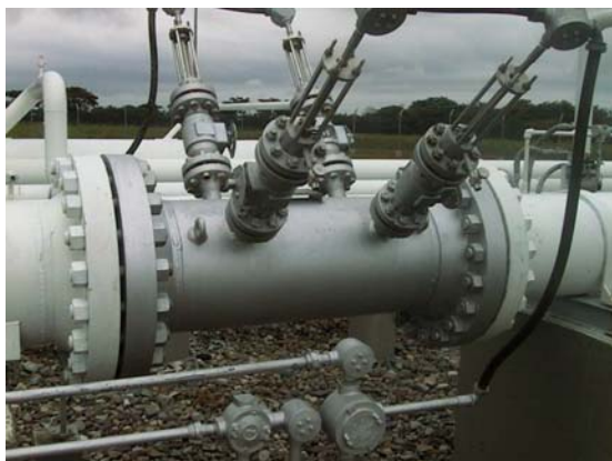
Figura 8. Spoolpiece y Transductores Ultrasónicos
