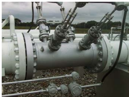
Figura 12. Spoolpiece y Transductores Ultrasónicos
