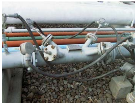
Figura 16. Spoolpiece y Transductores Ultrasónicos
