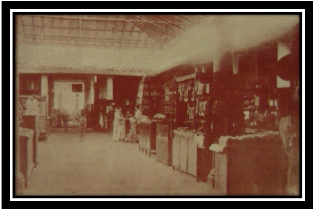
Figura 84. Galería central del mercado - sección de mercancías. 556
