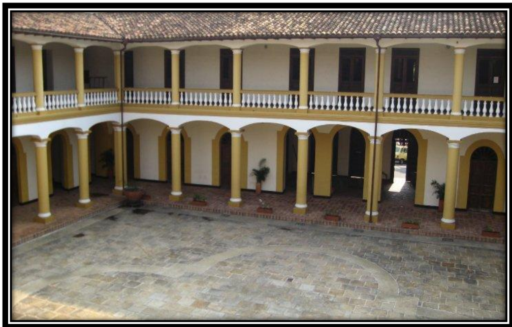
Figura 44. Obras de restauración interior. 291
