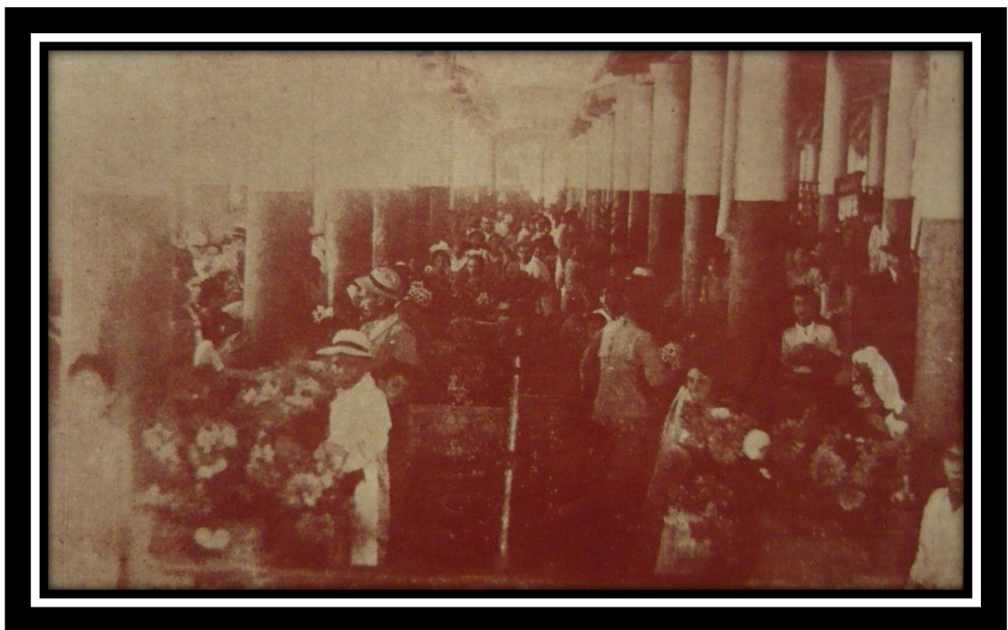
Figura 85. Galería de hortalizas y flores, construida de cemento armado. 557
