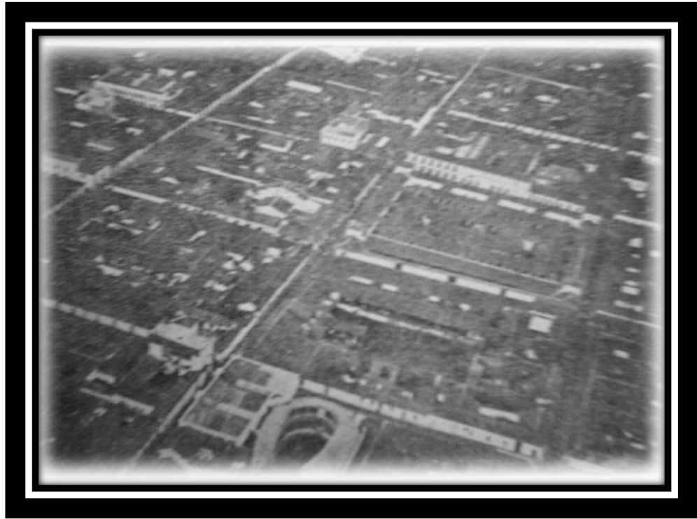
Figura 65. Fotografía de Bucaramanga que incluye vista aérea del Teatro Garnica.
