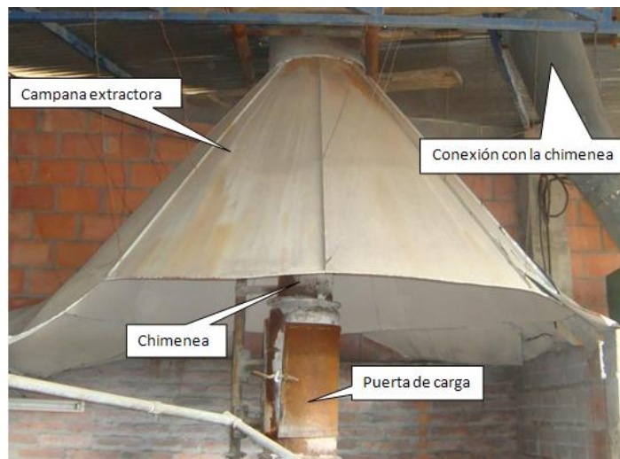
Figura 4 Fotografía de la Chimenea del horno
