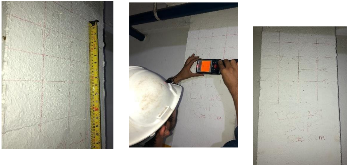
Figura 33. Toma de datos con medidor de escáner de refuerzo
