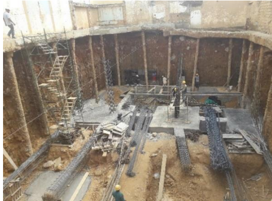
Figura 3. Vista general avance en cimentación
