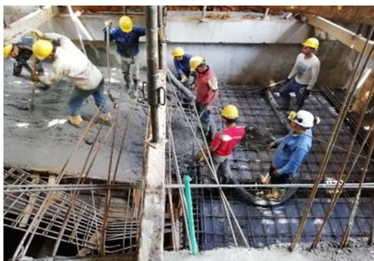
Figura 20. Fundida de la rampa entre los niveles N-3.80 y N-1.15. Fuente: Peralta Ingeniería
