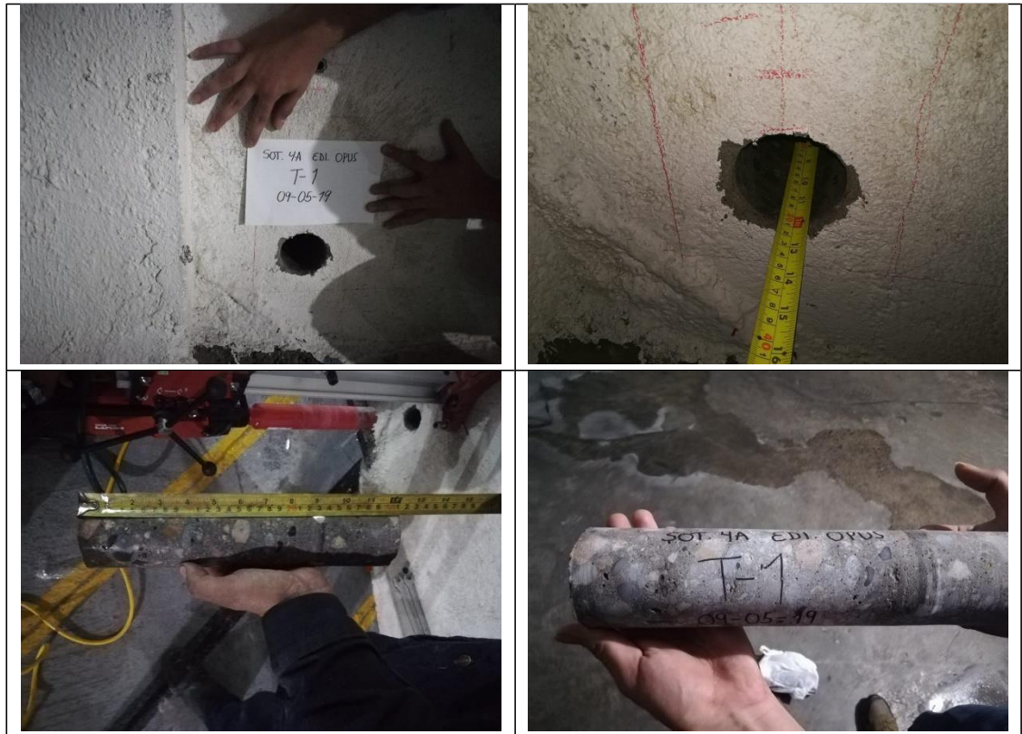
Figura 25. Extracción de núcleos edificio OPUS. Testigo 1 Sótano 4 a .
