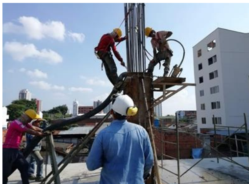
Figura 23. Fundida de las columnas 8, 9 y 10. Fuente: Peralta Ingeniería
