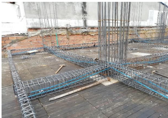
Figura 19. Vigas armadas con los torones instalados. Fuente: Peralta Ingeniería
