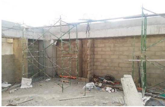
Figura 8. Vista general de muro de mampostería con sus respectivas trabas.
