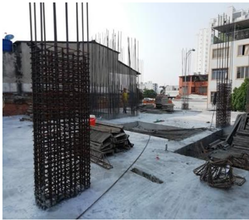
Figura 22. Armado de las columnas entre niveles N+3.75 y N+6.25. Fuente: Peralta Ingeniería
