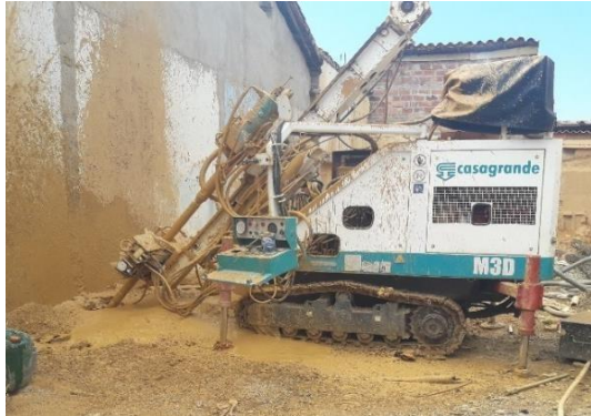
Figura 1. Perforación pilote inclinado (PI5).
