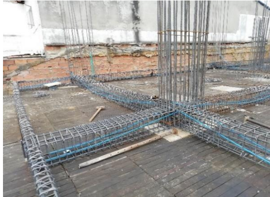
Figura 6. Vigas armadas con los torones ya colocados.
