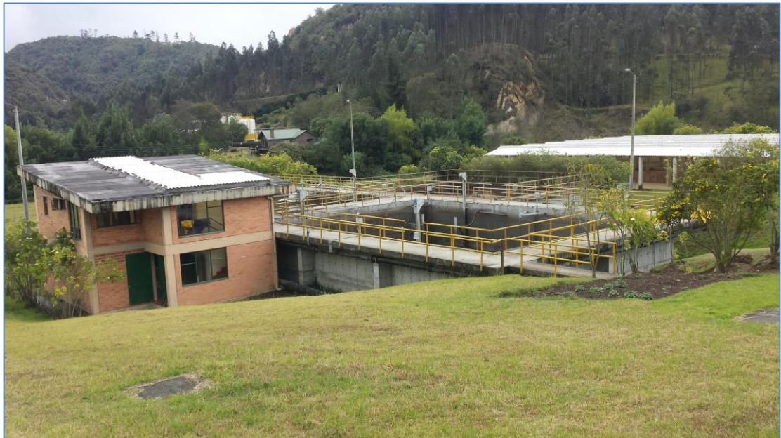
Fotografía 14. Zonas verdes PTAR La Calera.
