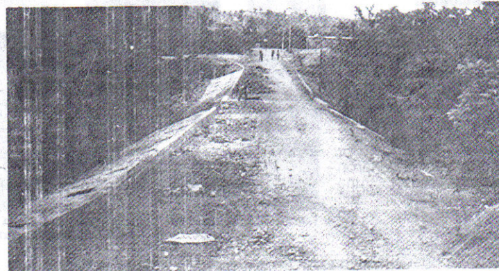
RELLENO Y EMPEDRADO PUENTE LA CORDILLERA
