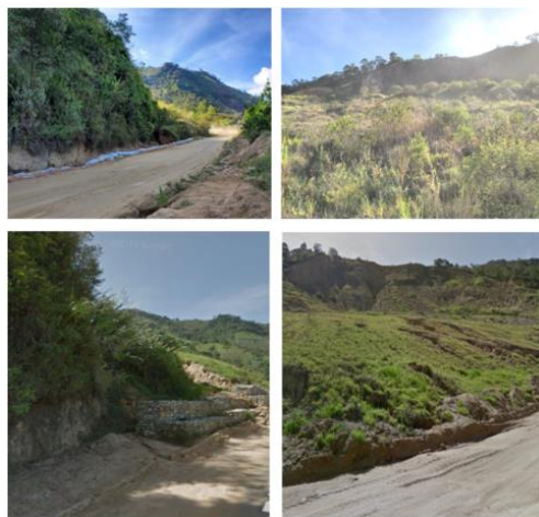
Figura 26. Registro fotográfico de campo en el Km 12
