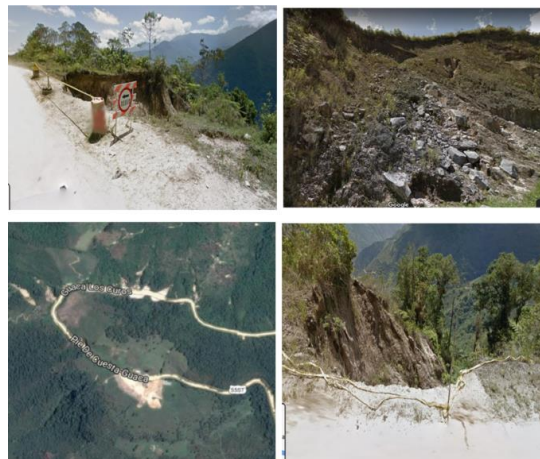
Figura 32. Registro fotográfico de campo en el Km 42
