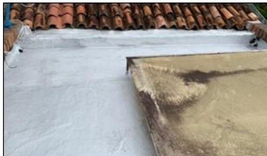
Figura 19. Impermeabilización de placa.
