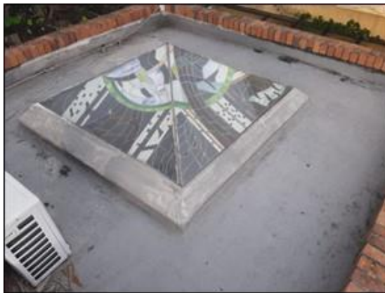
Figura 18. Fotografía cubierta a intervenir.
