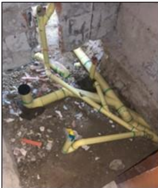
Figura 4. Registro fotográfico de instalación sanitaria.
