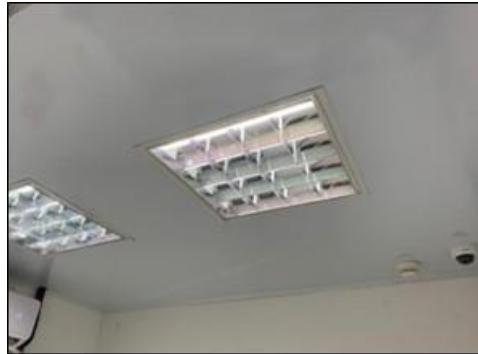
Figura 22. Fotografía nuevo cielo raso en PVC.
