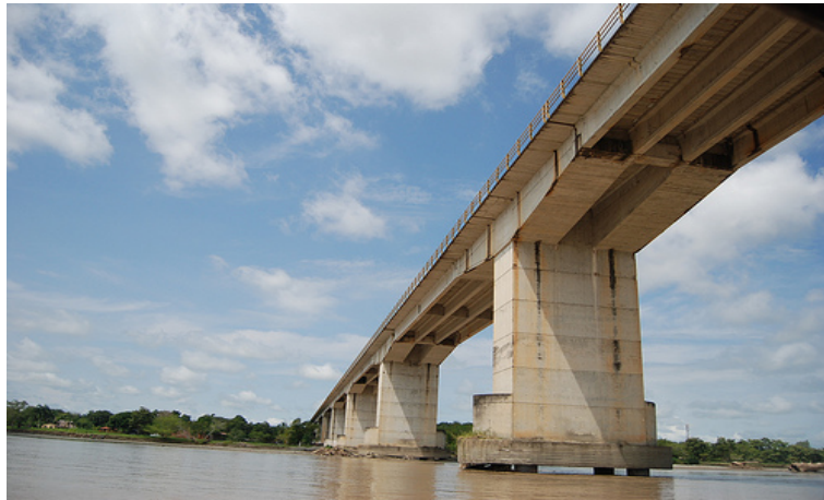
Figura 3.0.4: Puente Carlos Lleras Restrepo, Cauca-Antioquia
