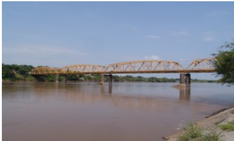
Figura 3.0.5: Puente Salgar, Tolima
