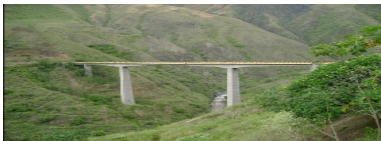
Figura 3.0.1: Puente Juanambú, Nariño
