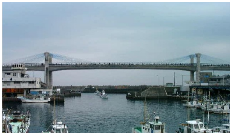
Figura 3.0.12: Puente Odawara Blueway en Japón, 1994
