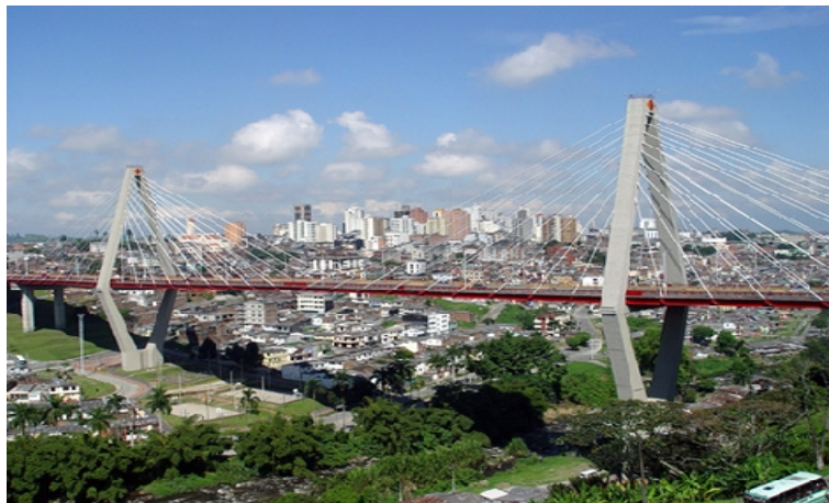
Figura 3.0.3: Viaducto César Gaviria Trujillo
