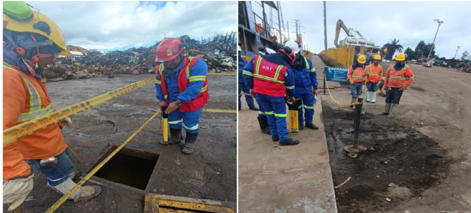
Figura 6. Soporte fotográfico de la verificación de la presencia de tensión en área de demolición y excavación para obra de Reparación Placa Y Baches Patio.
