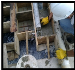
e) Colocación de las termocuplas
