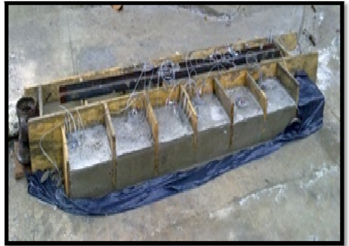
b) Proceso de Desencofrado
