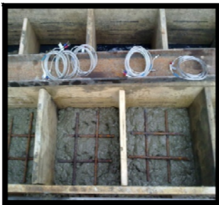
d) Colocación del refuerzo
