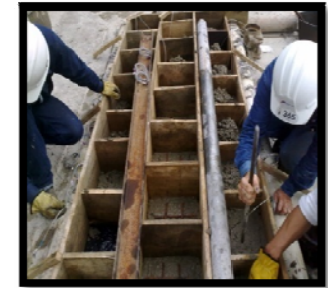
f) Vibrado de la mezcla
