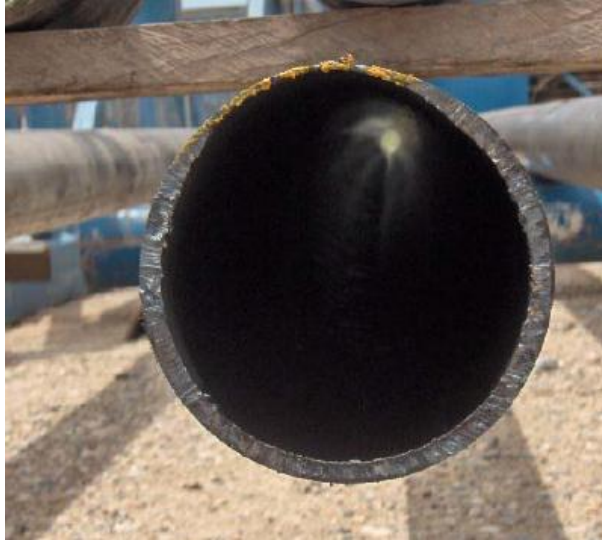
Figura 7. Desgaste en tuberías de revestimiento
