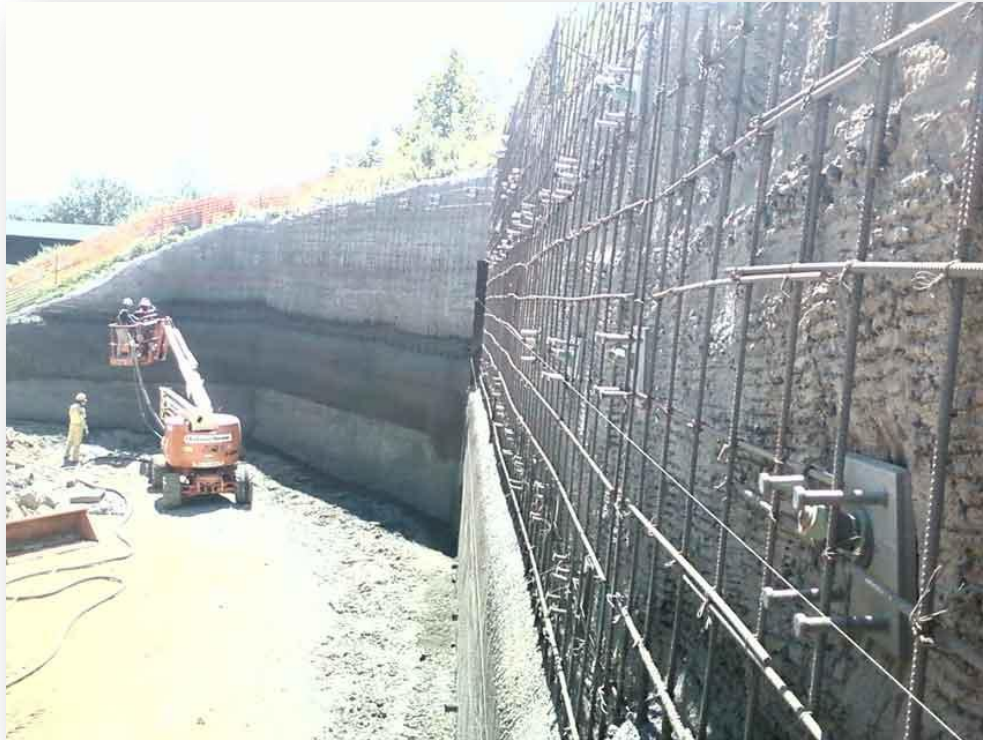
Figura 39. Construcción pantalla anclada
