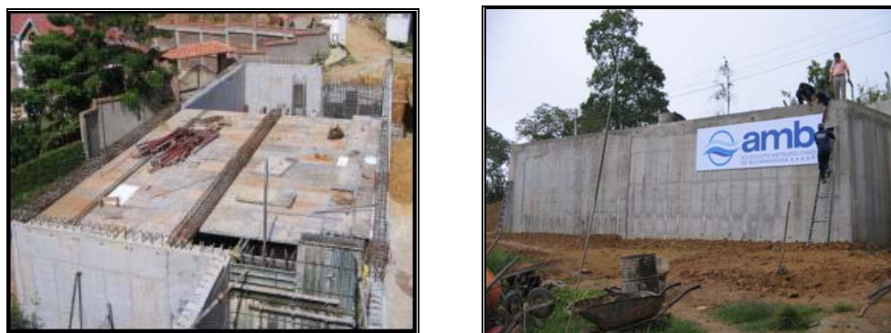
Figura 4. Construcción tanque de almacenamiento La Malaña
