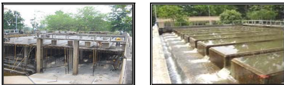
Figura 1. Sistema de presedimentación
