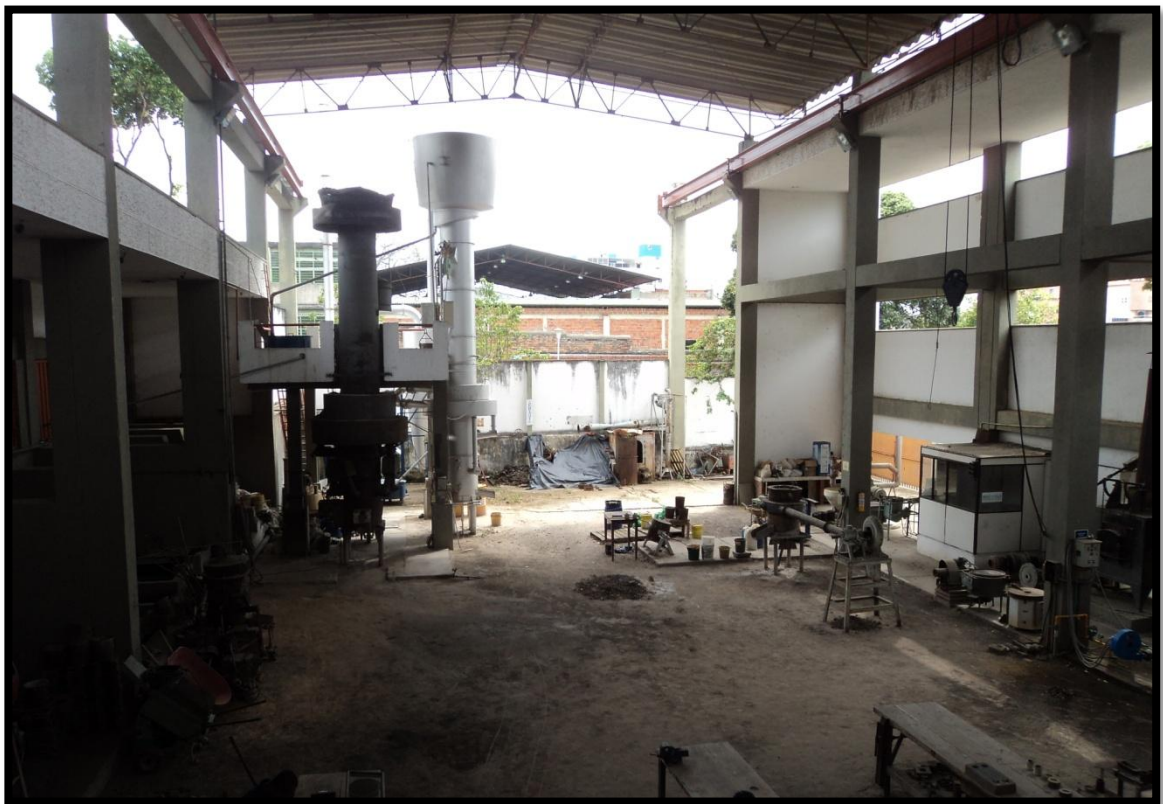
Figura 51: Patio de fundición planta de aceros
