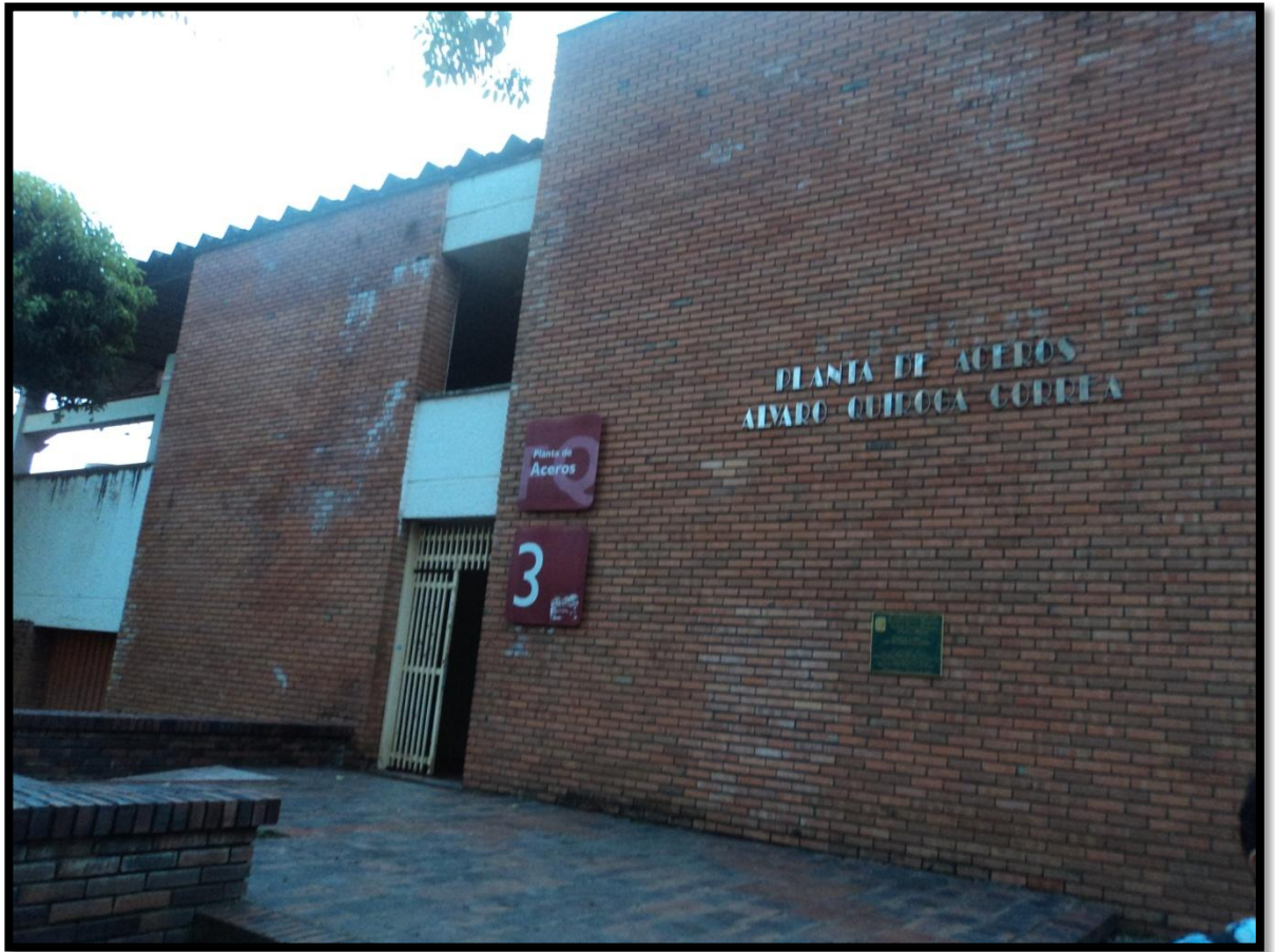
Figura 37: Edificio planta de aceros
