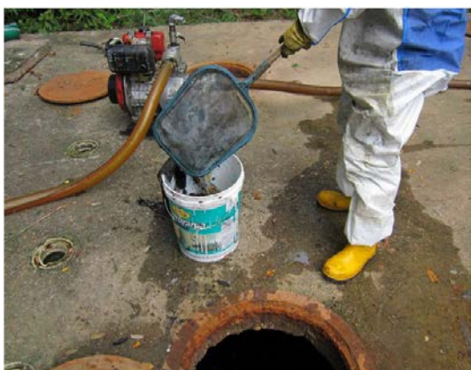
Figura 3. Mantenimiento Sistemas de Tratamiento de Aguas Residuales Domésticas.
