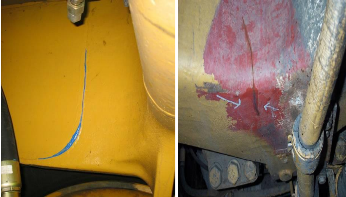
Figura 9. Causas de Defectos y Deterioro
