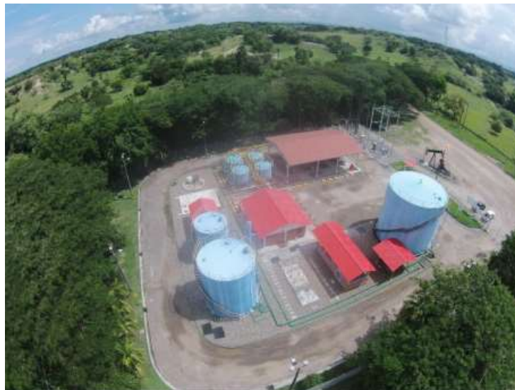
Imagen 1. Vista Panorámica de la Planta de Inyección de Agua en Campo Palagua
