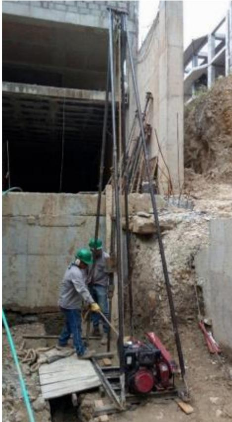
*Figura 8.* Ensayo de penetración estándar S5.
