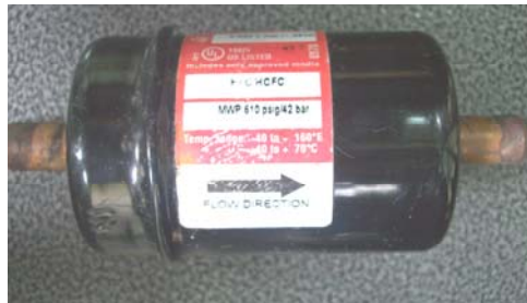
Figura 18. Filtro ubicado en la línea de líquido.
