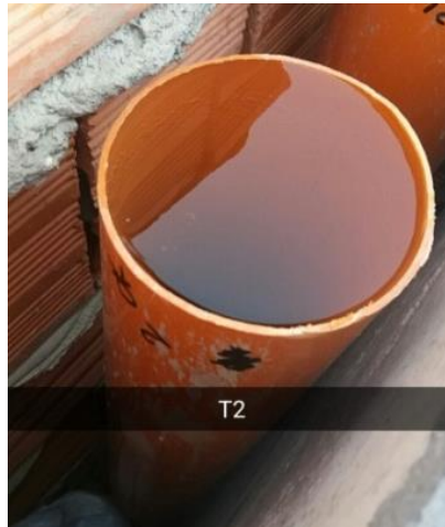
Figura No. 9 Fotografía verificación prueba de estanqueidad.
