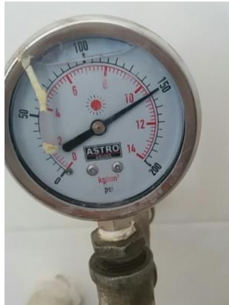
Figura No. 8 Fotografía verificación prueba de presión hidráulica.
