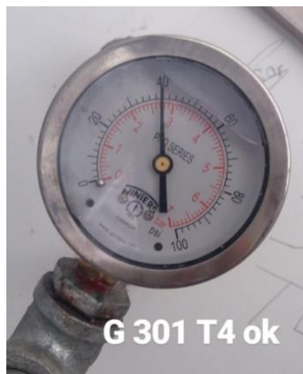
Figura No. 10 Fotografía verificación prueba de presión red de gas.
