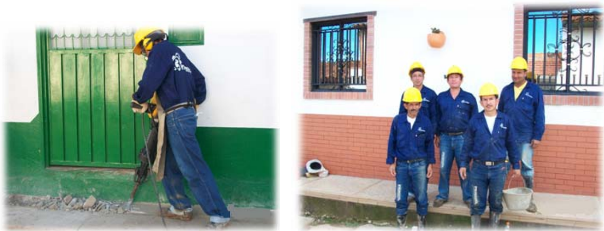
Figura 8. Operarios e Instalaciones
