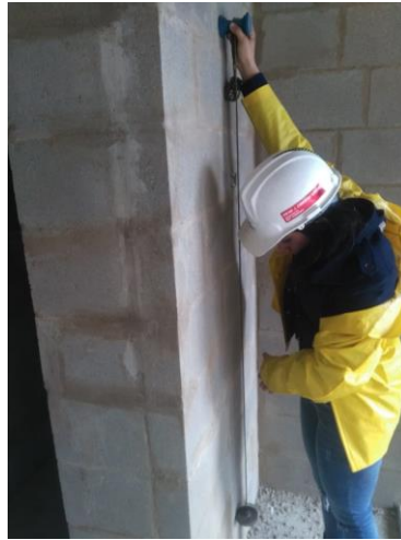
Figura 15. Revisión de muros con plomada.
