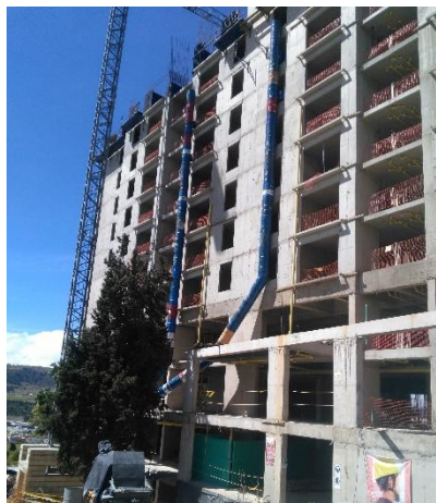
Figura 6. Estado del proyecto PARQUE DE LOS CACIQUES, al iniciar la práctica por el auxiliar.
