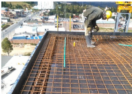
Figura 8. Armado de placa de cubierta torre B.
