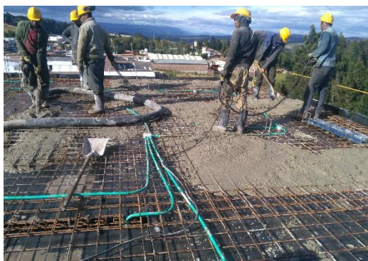
Figura 9. Fundida de placa de cubierta torre B, con su debido vibrado.
