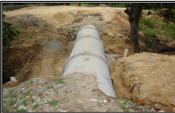
Figura No 9. Tubería instalada para el colector de Barro Blanco
