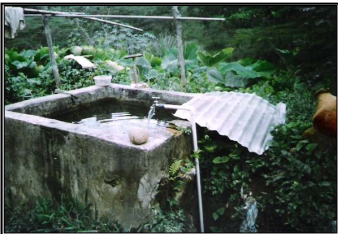
Figura No 5. Control de presión de agua en el punto de entrega al usuario
