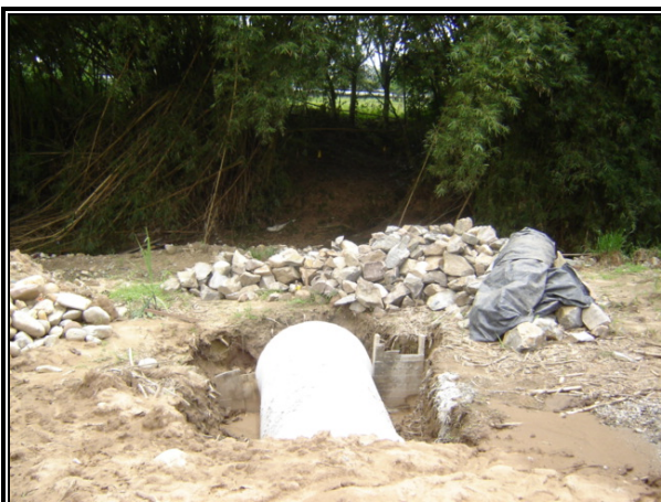
Figura No 7. Paso elevado del colector de Suratoque sobre la quebrada
