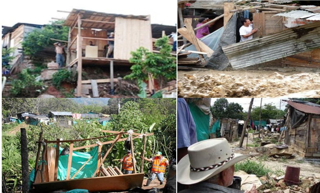
Figura 11. Construcción de cambuches finca Suratoque Florida Blanca
