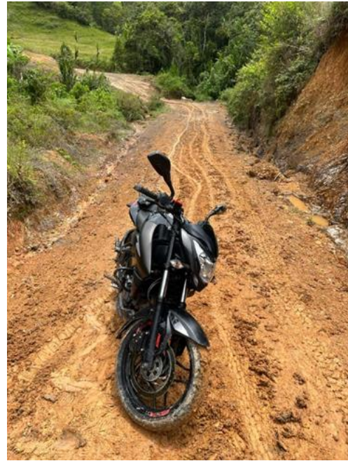
Fig. 10 Estado de las vías
