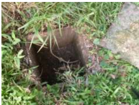
Figura 55 Ubicación cámara de inspección electrodo malla de puesta a tierra RACK de comunicaciones
