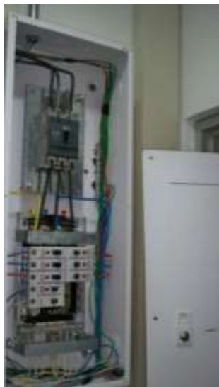
Figura 25 Barraje Tablero TD2.
