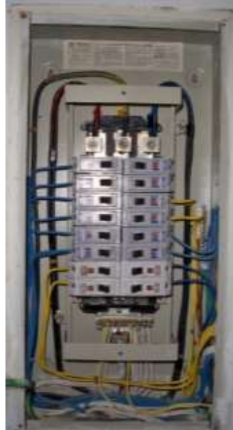
Figura 32 Barraje Tablero TM
