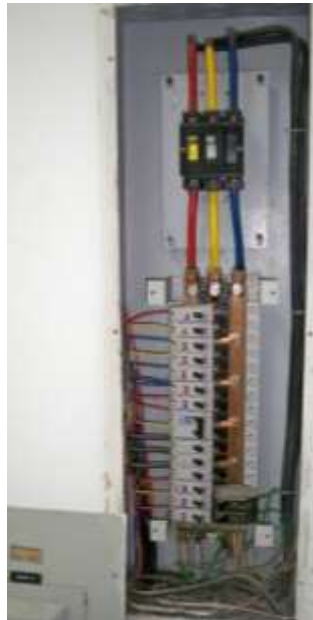
Figura 18 Barraje Tablero TD
