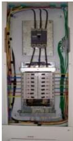
Figura 34 Barraje Tablero TD4
