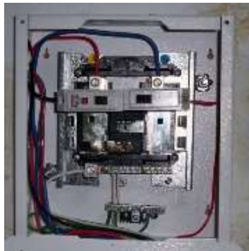
Figura 31 Barraje Tablero TRC.
