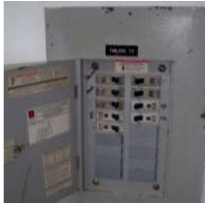
Figura 21 Barraje Tablero TG
