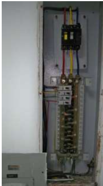
Figura 28 Barraje Tablero TJ.
