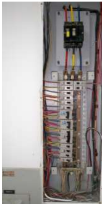
Figura 19 Barraje Tablero TE
