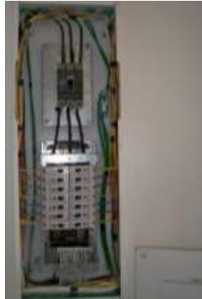
Figura 35 Barraje Tablero TD3.
