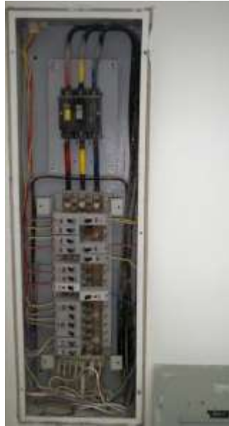
Figura 20 Barraje Tablero TF
