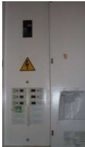
Figura 24 Barraje Tablero TD1
