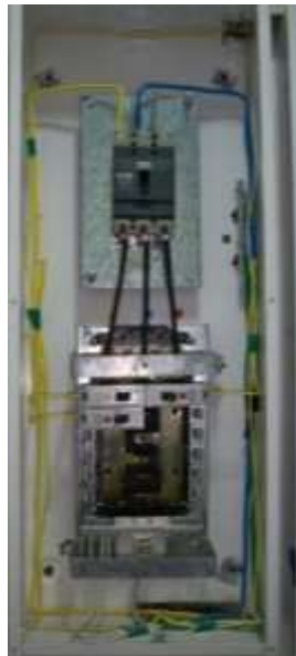
Figura 26 Barraje Tablero TR.
