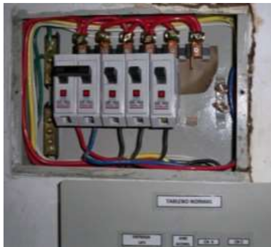
Figura 30 Barraje Tablero TN.
