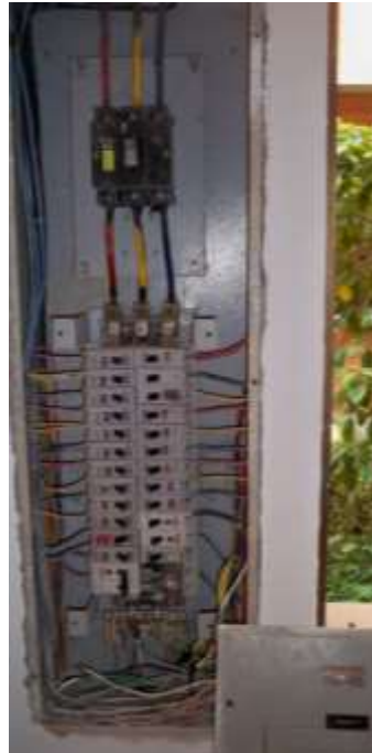
Figura 17 Barraje Tablero TC
