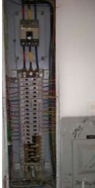
Figura 16 Barraje Tablero TB
