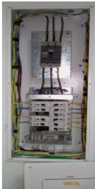
Figura 33 Barraje Tablero TD5
