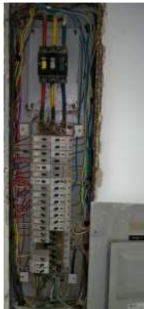
Figura 27 Barraje Tablero TI.
