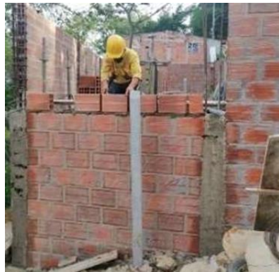
Figura 7 Construcción de cerramiento Torre 52-UIS contrato CW143075.
