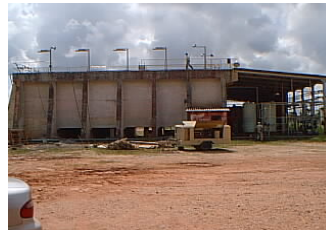
Fotografía 5. Sección 101: Planta de Clarificación y Potabilización.
