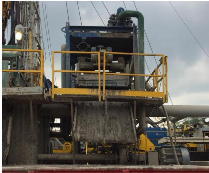
Figura 10. Limpiador de lodo pozo RIG-118
