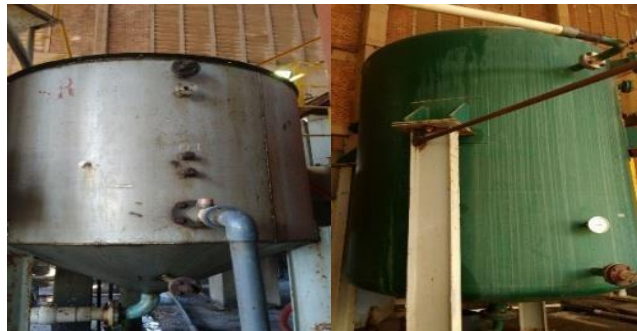
Figura 11. Tanque atmosférico de almacenamiento y enfriador. Adaptado de Fertilizantes Colombianos S.A
