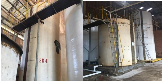
Figura 13. Tanques de Almacenamiento. Adaptado de Fertilizantes Colombianos S.A
