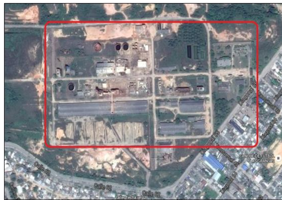
Figura 2. Imagen aérea de las instalaciones de FERTICOL S.A. Adaptado de Imágenes 2015 CNES/Astrium Datos del mapa. Google
