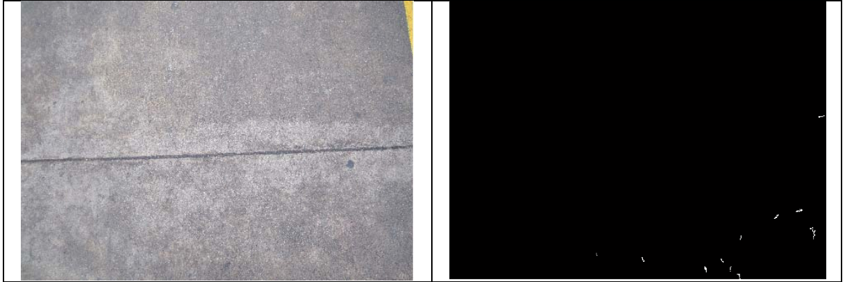
Figura 36. Imagen del pavimento sin fisuras
