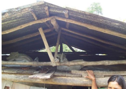
Fotografía 14. soleras en el techo de las casas .Fuente: El autor
